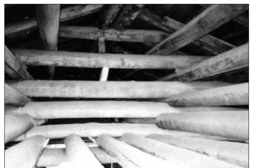
L'interiur d'ina lattida a Fidaz (survart da dadora): tschintg lains radunds furman il funs e trais las paraids. Els èn enchastrads culs lains da la paraid dal clavà (Fidaz 1999).
